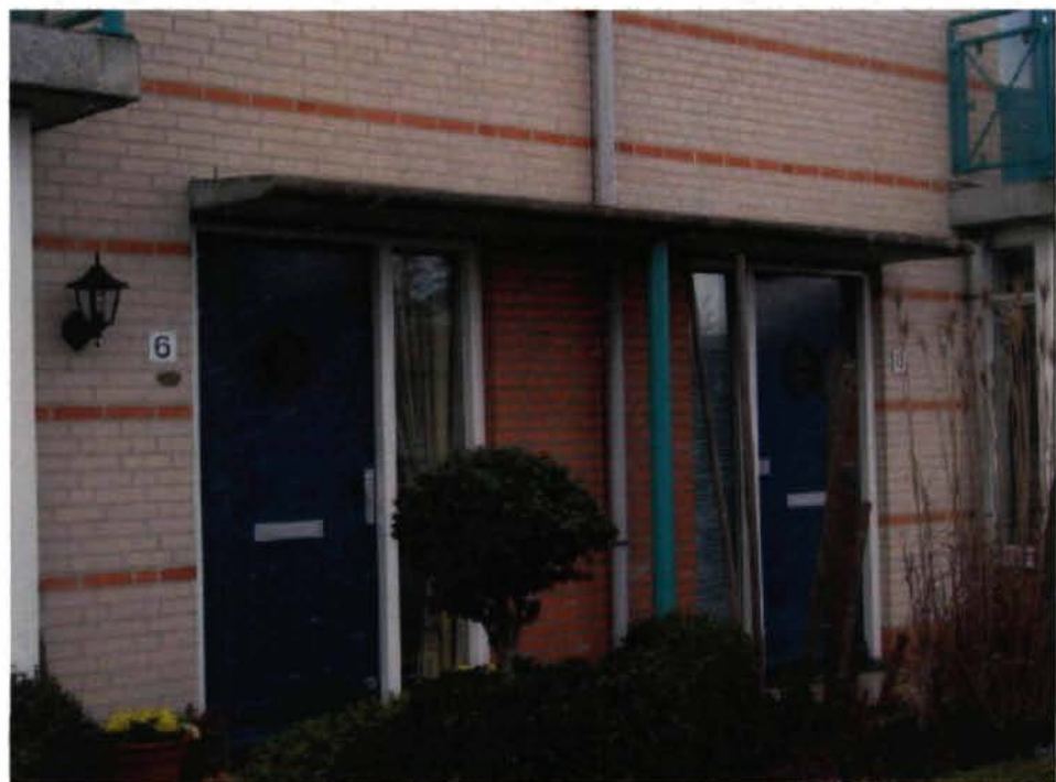
Sommige bewoners bevestigen lamp op aansluitpunt, sommige niet.
