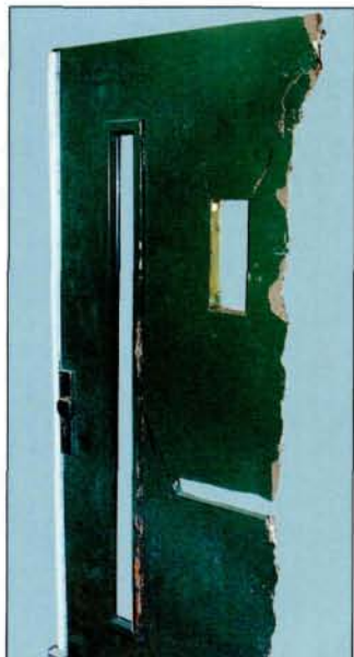
Foto boven: Buitendeur, met behulp van explosieven geopend bij politie-inval.
