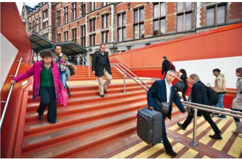
Gele antislipstroken op de trappen naar de metro.
