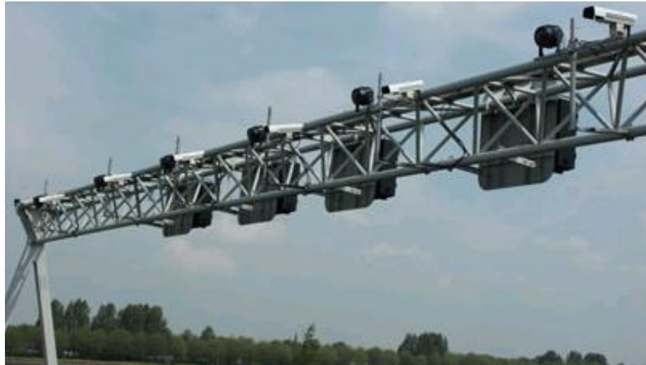
Vaste ANPR-opstelling op de A1. Deze camera's worden door Rijkswaterstaat gebruikt om files te bestrijden en de gelezen kentekens worden een jaar bewaard. Onder voorwaarden kunnen die gegevens ook aan politie en justitie ter beschikking worden gesteld.
