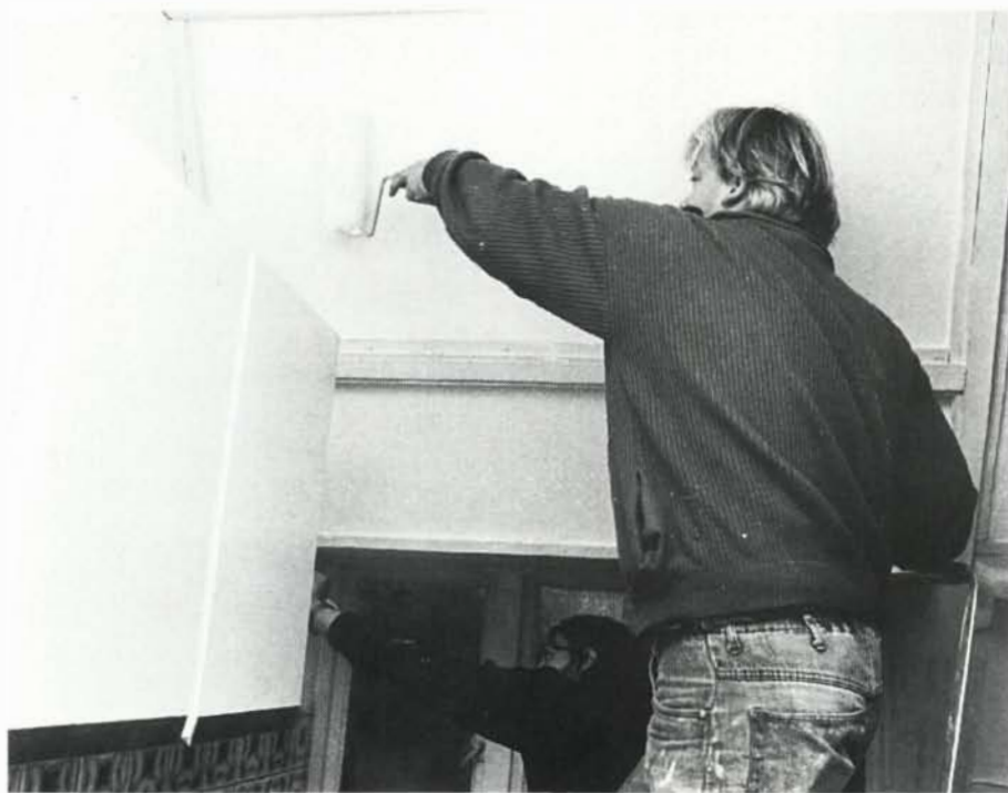
De bouwploeg aan het werk ... binnen ...
