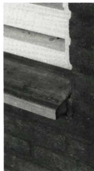
Boven: Raamdorpel van betonelement Links: Zwaar beschadigde raamdorpel
