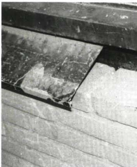
Boven: Raamdorpel van betonelement Links: Zwaar beschadigde raamdorpel
