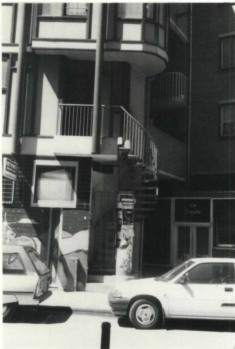
Afsluitbare, half in het gebouw geïntegreerde noodtrap (Sint Antoniesbreestraat).
