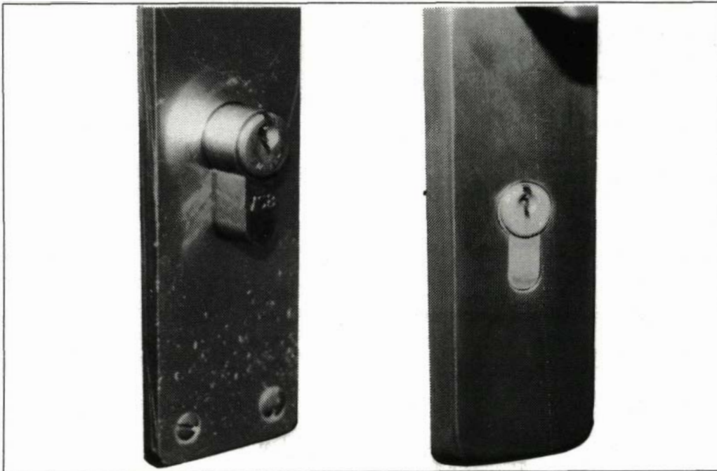
Te ver uitstekende cilinder en correct opgesloten cilinder
