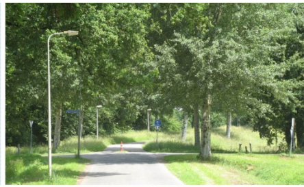
Belangrijke avondroute. Overdag prima. In de avond? Want eenzijdige verlichtingsarmaturen
