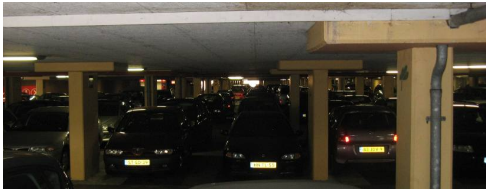
Foto 3 Duistere openbare ruimte: de parkeergarage
