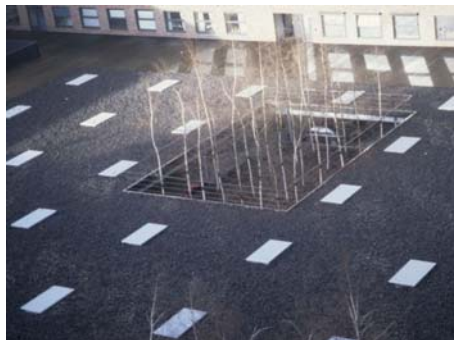
Valkinvulling op stenig dak (Rotterdam)
