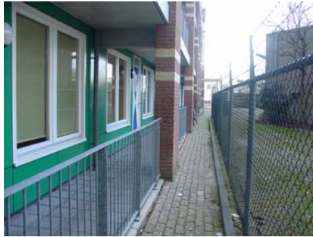
Passage tussen woningen en gebouw Show-band
