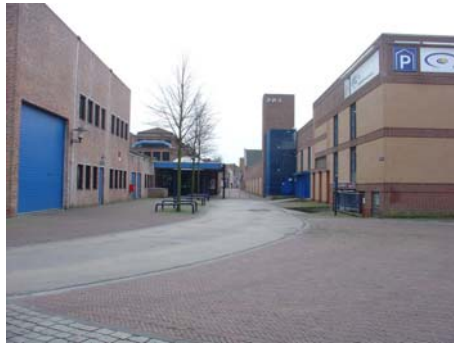
Walikerstraat toerit parkeergarage
