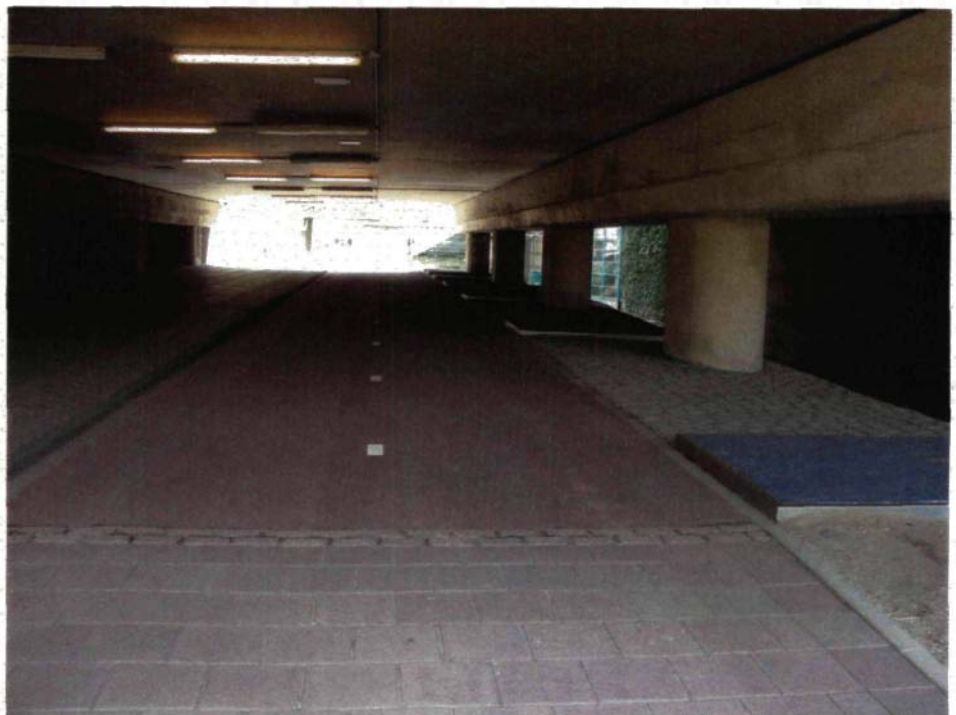
Fietstunnel noordzijde station: te lang, te laag en met een donkere verdiepte zijstrook waarop onvoldoende zicht is
