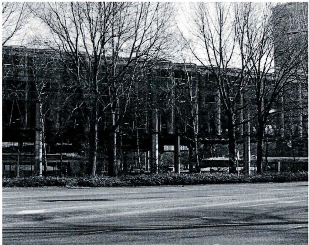
Beheer: parkeergarage boven busstation vereist specifiek beheer, Amstelveen
